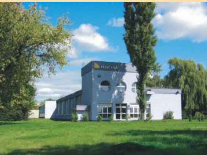
Centrum Dystrybucji oraz Zakład Produkcyjny
